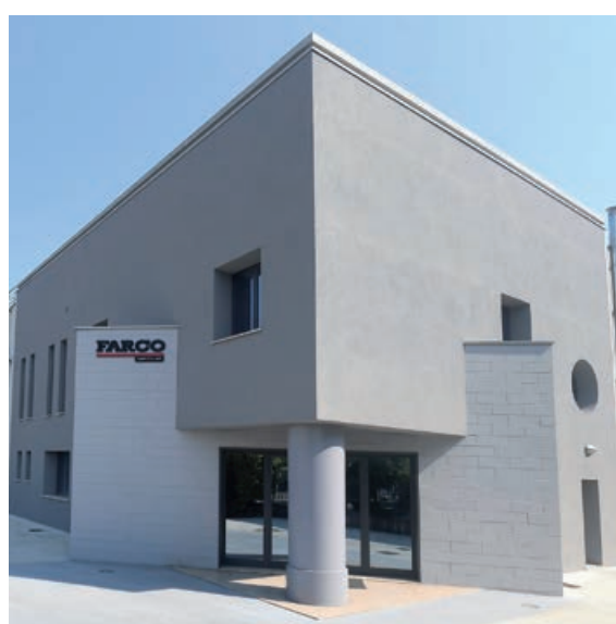
Sede di Torbole Casaglia, Ingresso di via Industria
