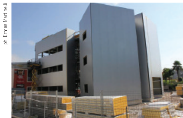
Vista dell'involucro in pannelli sandwich
