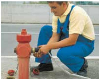
La manutenzione di naspì e idranti è definita nella norma UNI EN 671 parte terza, mentre per le alimentazioni idriche (centrali di pompaggio o altro), il riferimento è alla norma UNI 10779, che a sua volta richiama, per le parti specifiche di manutenzione, la norma UNI EN 12845.
